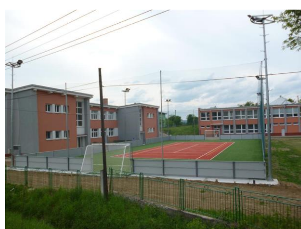
ZŠ Kotešová, multifunkčné ihrisko
