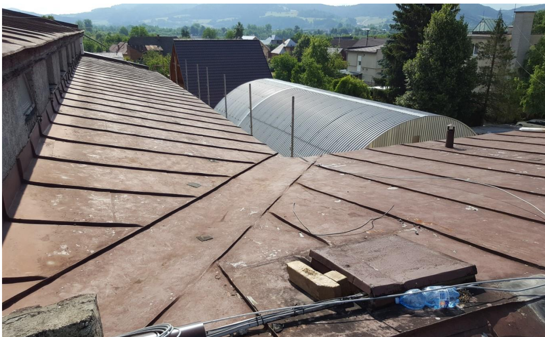
Budova OU pred rekonštrukciu strechy.
