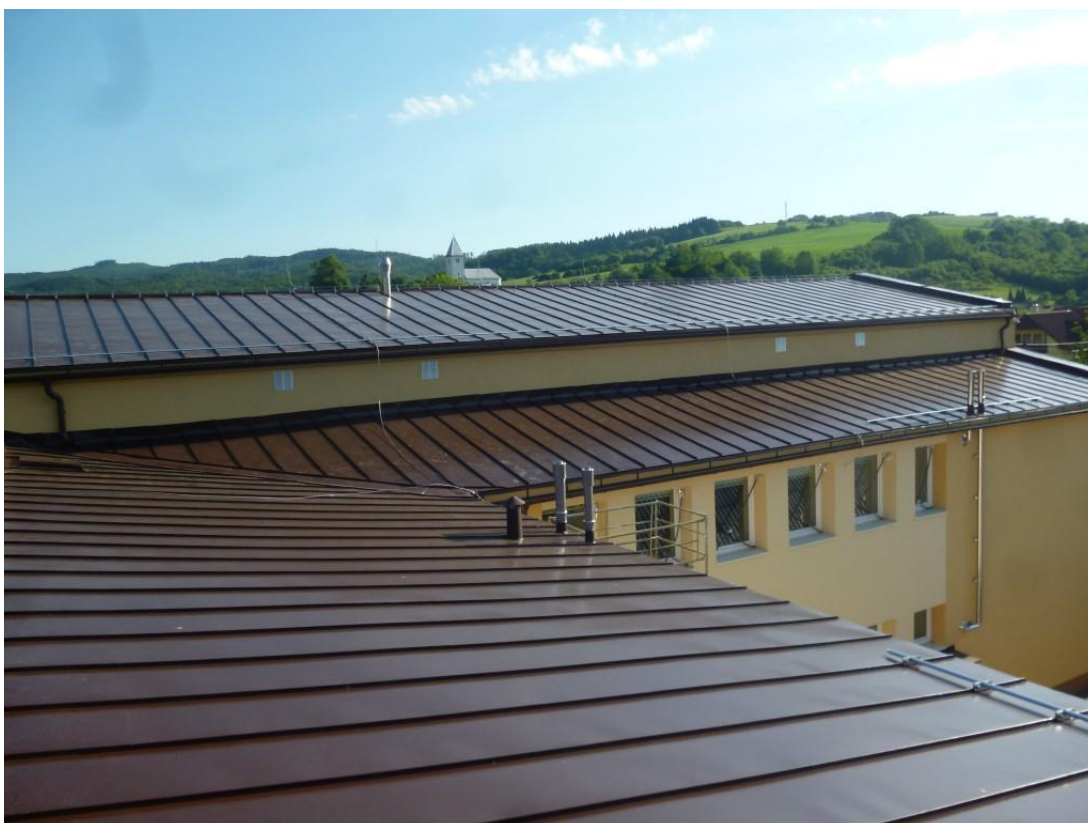
Budova OU po rekonštrukcii strechy.
