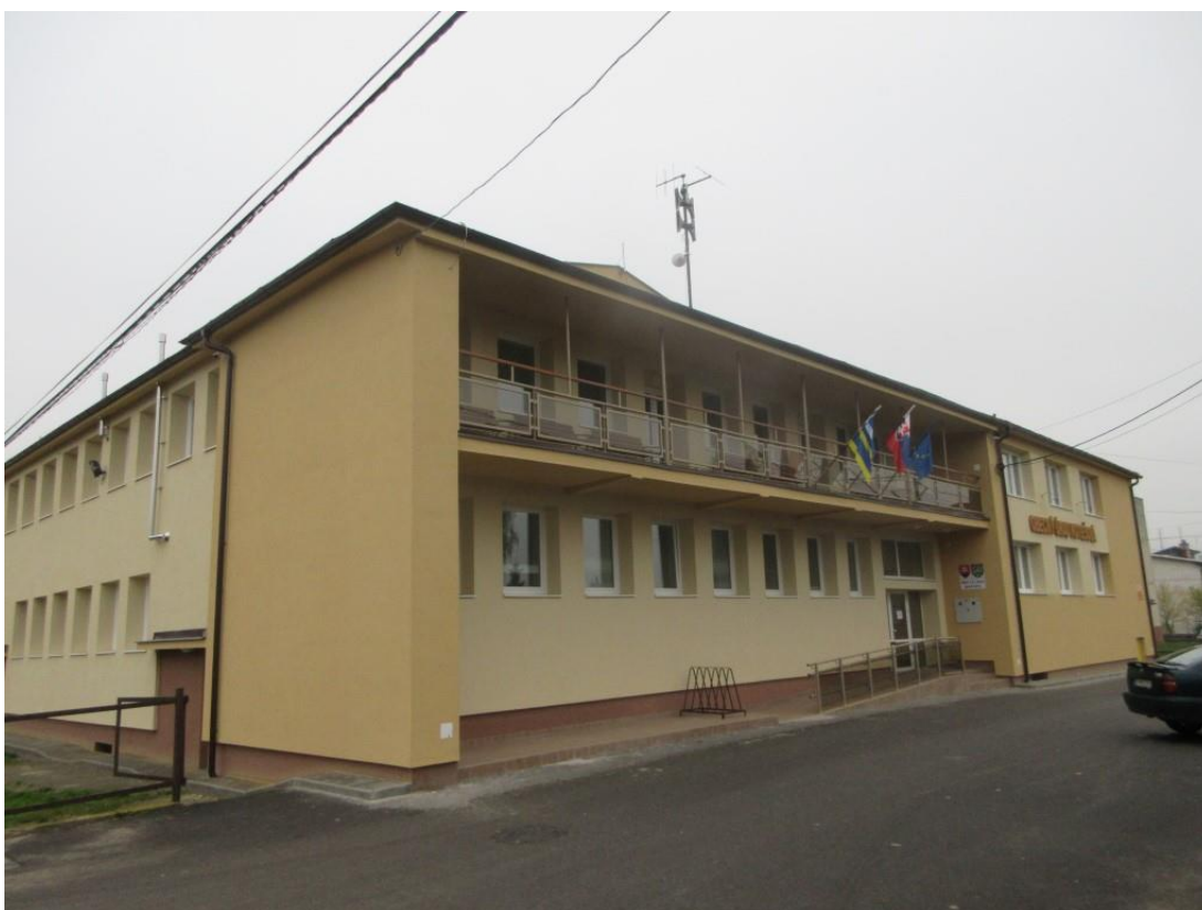
Budova OU po rekonštrukcii.
