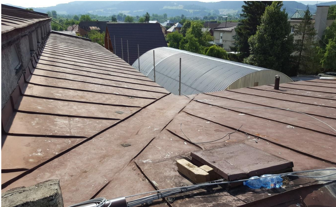
Budova OU pred rekonštrukciu strechy.
