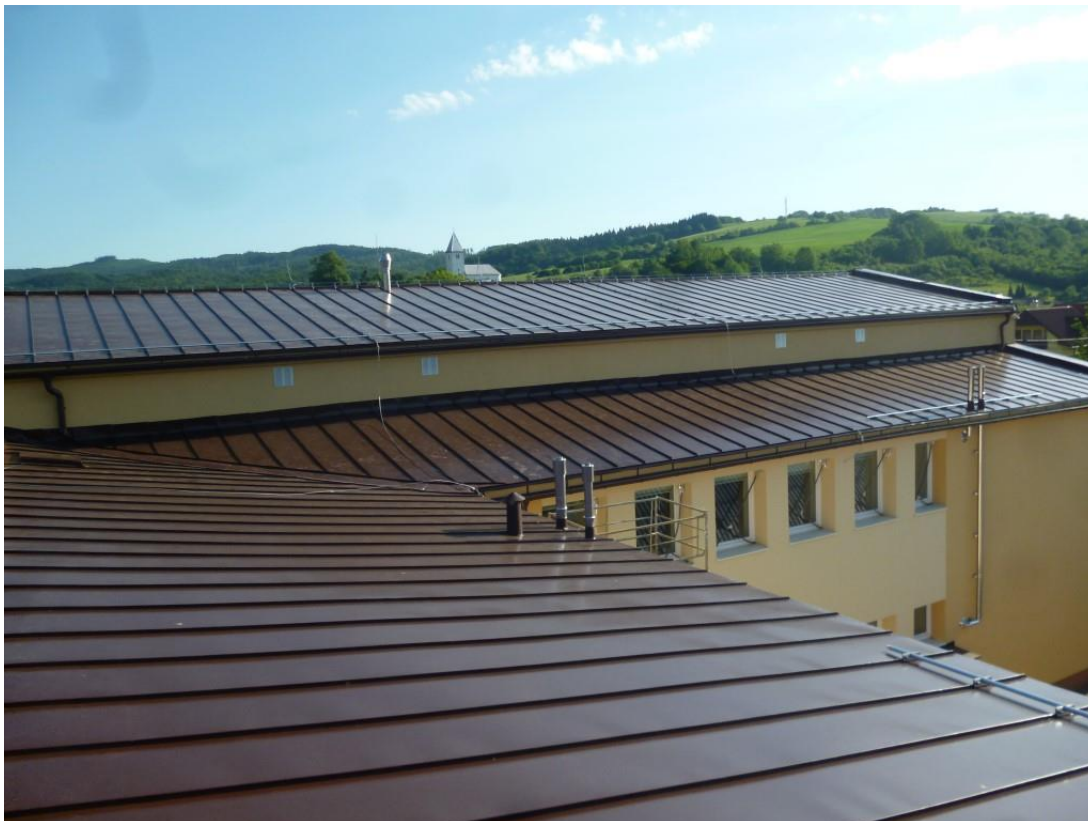
Budova OU po rekonštrukcii strechy.
