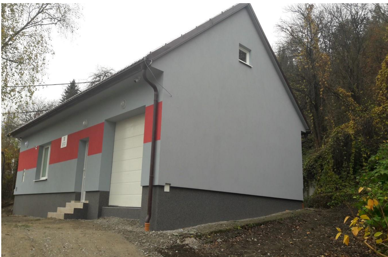
Budova DHZ Oblazov po rekonštrukcii.
