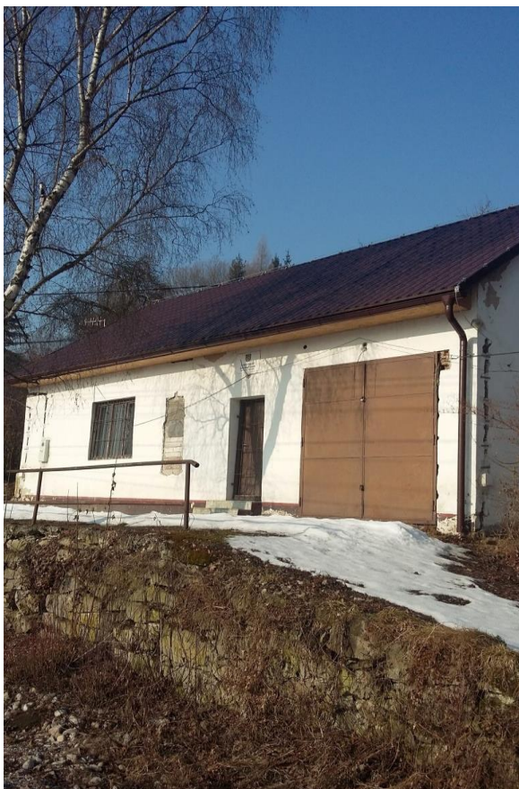
Budova DHZ Oblazov pred rekonštrukciou.
